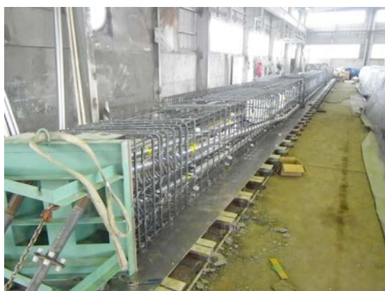
バイプレ工法セグメント桁の製造状況
