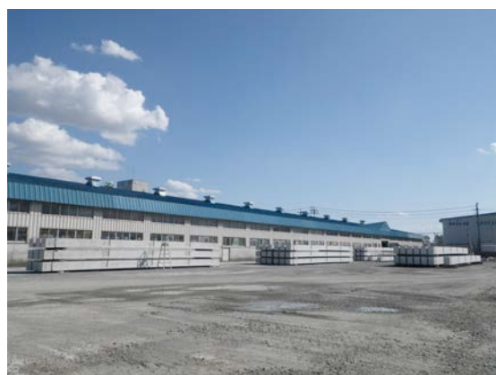
プレテン桁製造棟
