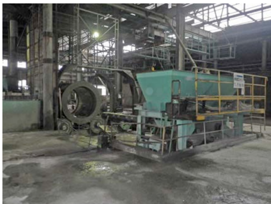
ヒューム管の製造状況
