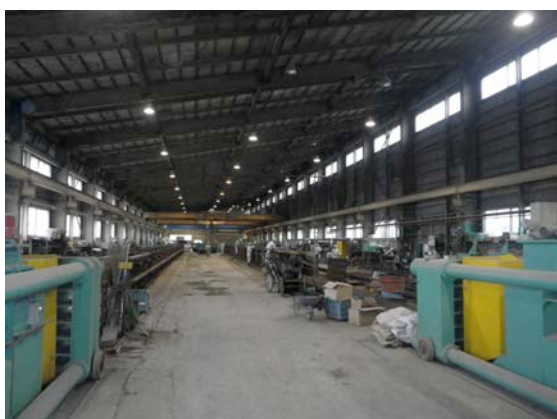
プレテン桁の製造状況
