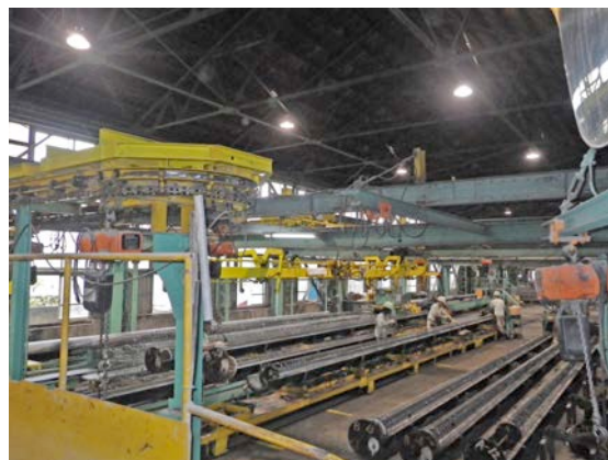
ポールの製造状況
