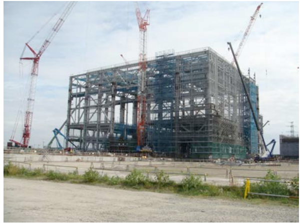
建設中のタービン建屋 1 号機
