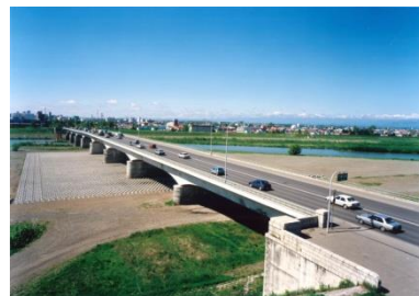
解体前の旧十勝大橋
