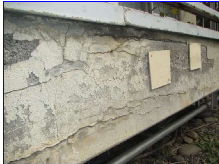
バルコニー先端部の劣化(32 年経過)、凍害危険度4
