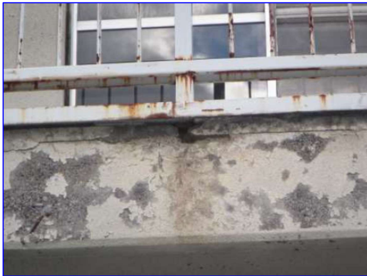
バルコニー先端部の劣化(32 年経過)、凍害危険度4
